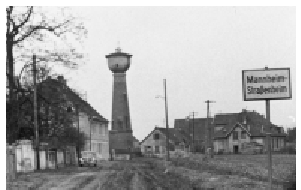
Trotz der geringen Dorfgröße wird in Straßenheim zu Beginn des 20. Jahrhunderts ein eigener Wasserturm errichtet. 1907 in Betrieb genommen, sorgt er bis in die 1930er Jahre für ausreichenden Druck in den Wasserleitungen, ehe Straßenheim nach der Eingemeindung an das Mannheimer Wasserleitungsnetz angeschlossen wird. Foto von 1951.
