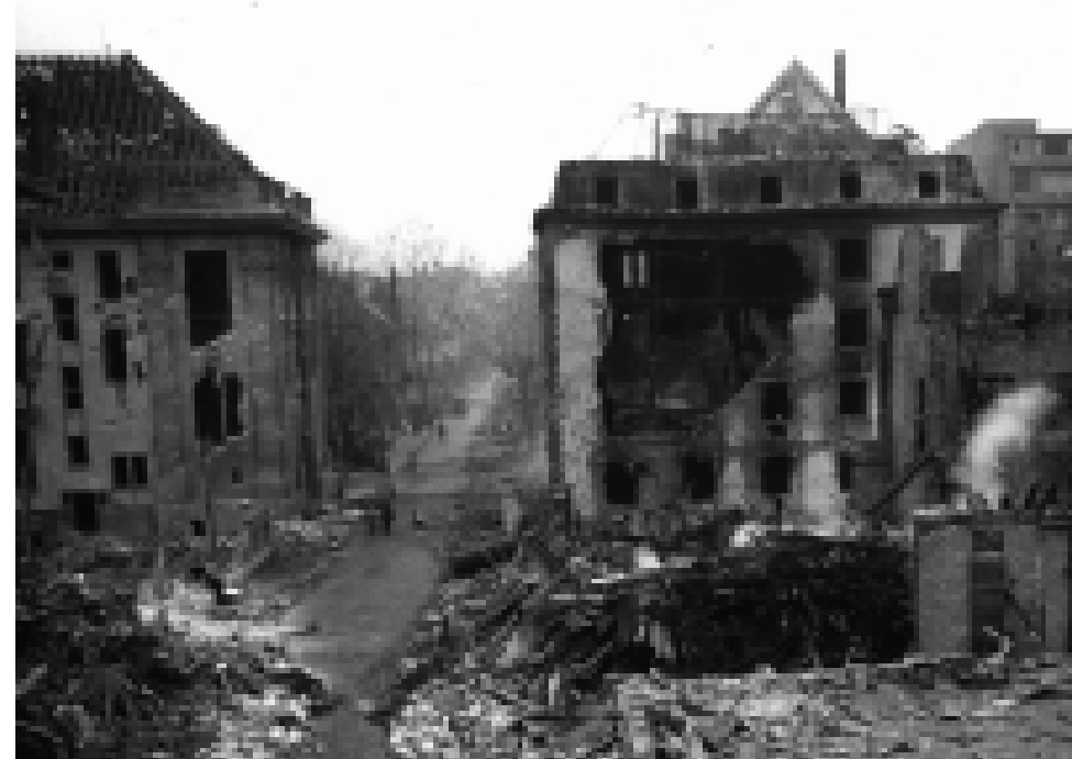
Im 2. Weltkrieg schwer beschädigt, wird das Gebäude 1950 wiederaufgebaut.
