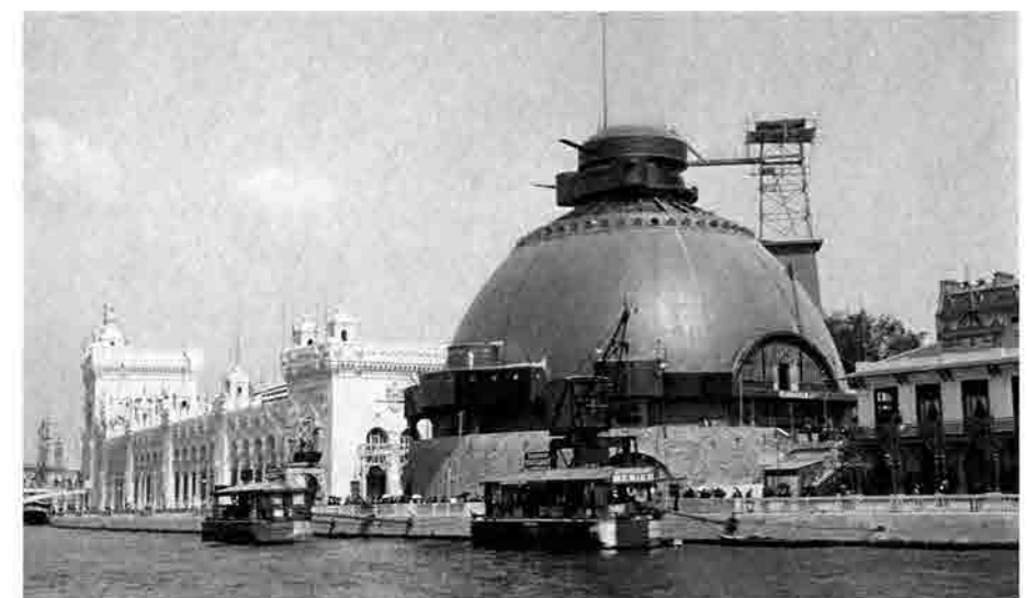
Bei der Weltausstellung in Paris 1900 stellt Mohr & Federhaff einen elektrisch betriebenen Portalkran vor.
