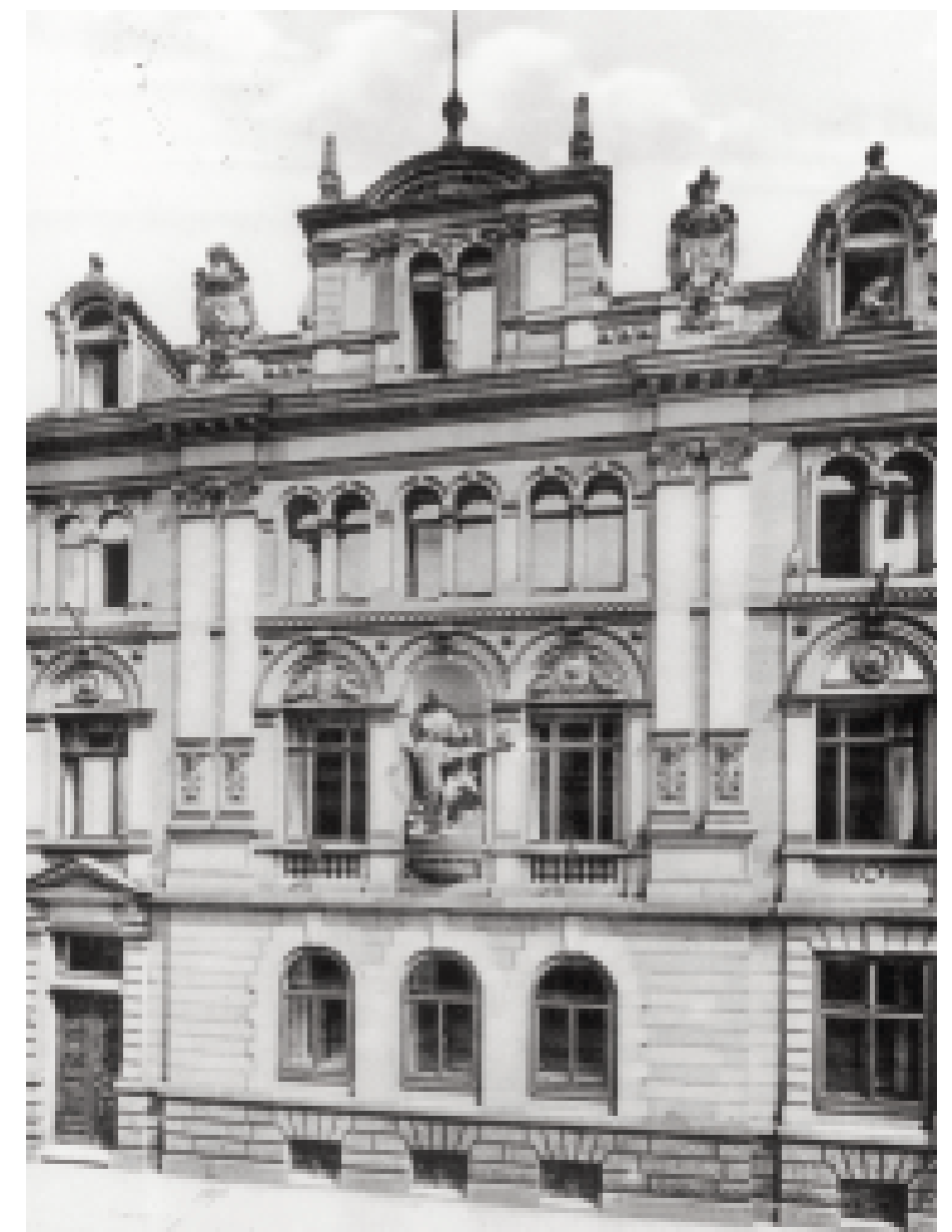
Das repräsentative Gebäude in B 1, 7b, 1904 für die Handelskammer erbaut, wird 1926 von der Handwerkskammer erworben. Es bleibt ihr Sitz bis 1933, als die Handwerkskammer im Zuge der nationalsozialistischen „Gleichschaltung“ zerschlagen wird.
