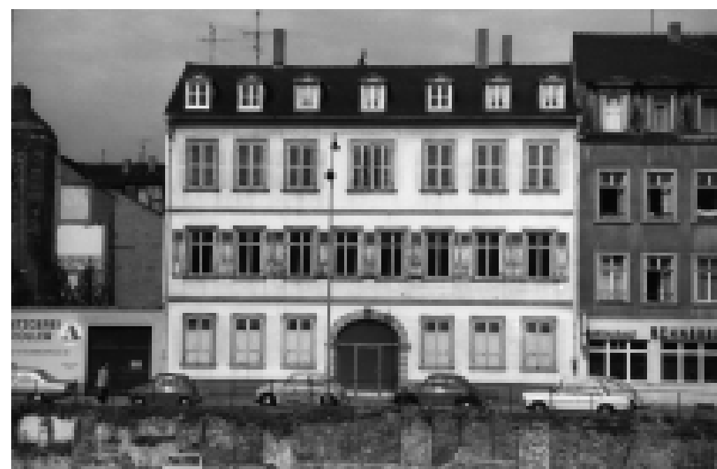
Das Gebäude D 4, 4 vor der Sanierung, 1973/74. Zu dieser Zeit wird es als Türkisches Begegnungszentrum genutzt. Das benachbarte Quadrat D 3 ist unbebaut und dient als Parkplatz.
