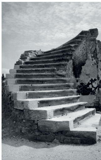
Treppe eines zerstörten Hauses in Mannheim, O 3, 10, ca. 1945
